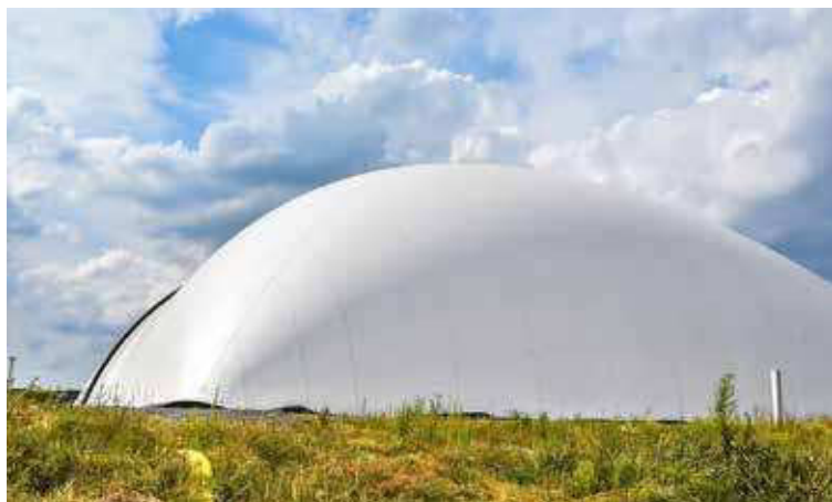
Der Niederdruck-Gasspeicher ist für die flexible Energieversorgung wichtig, das Speichervolumen beträgt bis zu 15.000 m 3 Reingas.
