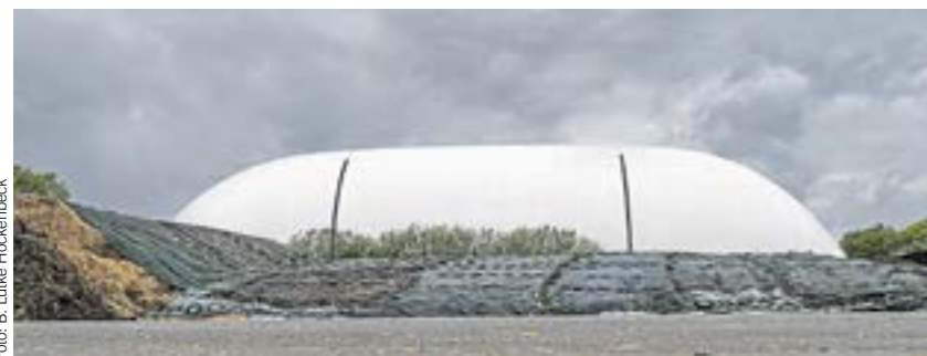
Zwei Energiespeicher auf einem Bild: Im Hintergrund ist der Gasspeicher, das „Tüttendorfer Ei“, zu sehen. Im Vordergrund liegt Silage. Sie speichert Sonnenenergie von der Ernte bis zum Einsatz in der Biogasanlage.
